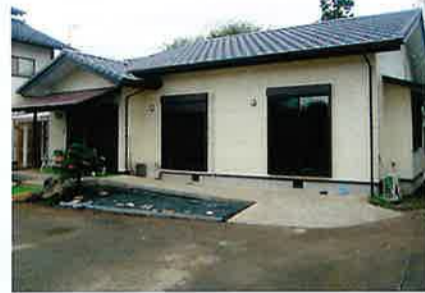
▲夫婦二人暮らしの生活を考え二階部分を完全に撤去。コンパクトな平屋として生まれ変わった外観。玄関へ続くスロープも設置。
