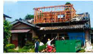
▲住宅の二階部分を撤去。一階部分は構造体だけを残したスケルトンリフォームで高気密・高断熱の平屋に大改造。
