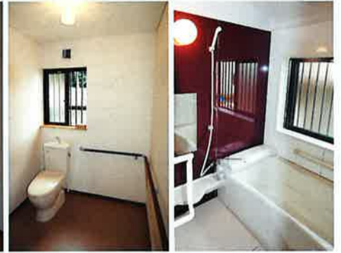
▲敷居などの段差を全てなくし、間仕切りや建具幅を拡大。廊下やトイレ、浴室、洗面所なども手すりを設置し、玄関から室内へは車いすでも移動しやすいようスロープを設け十分に広さを確保。セカンドライフを考慮したバリアフリーな住まいに。
