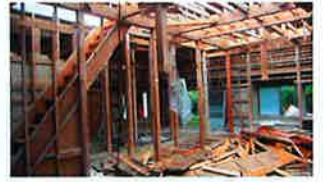
▲住宅の二階部分を撤去。一階部分は構造体だけを残したスケルトンリフォームで高気密・高断熱の平屋に大改造。
