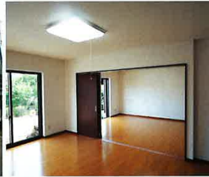
▲敷居などの段差を全てなくし、間仕切りや建具幅を拡大。廊下やトイレ、浴室、洗面所なども手すりを設置し、玄関から室内へは車いすでも移動しやすいようスロープを設け十分に広さを確保。セカンドライフを考慮したバリアフリーな住まいに。
